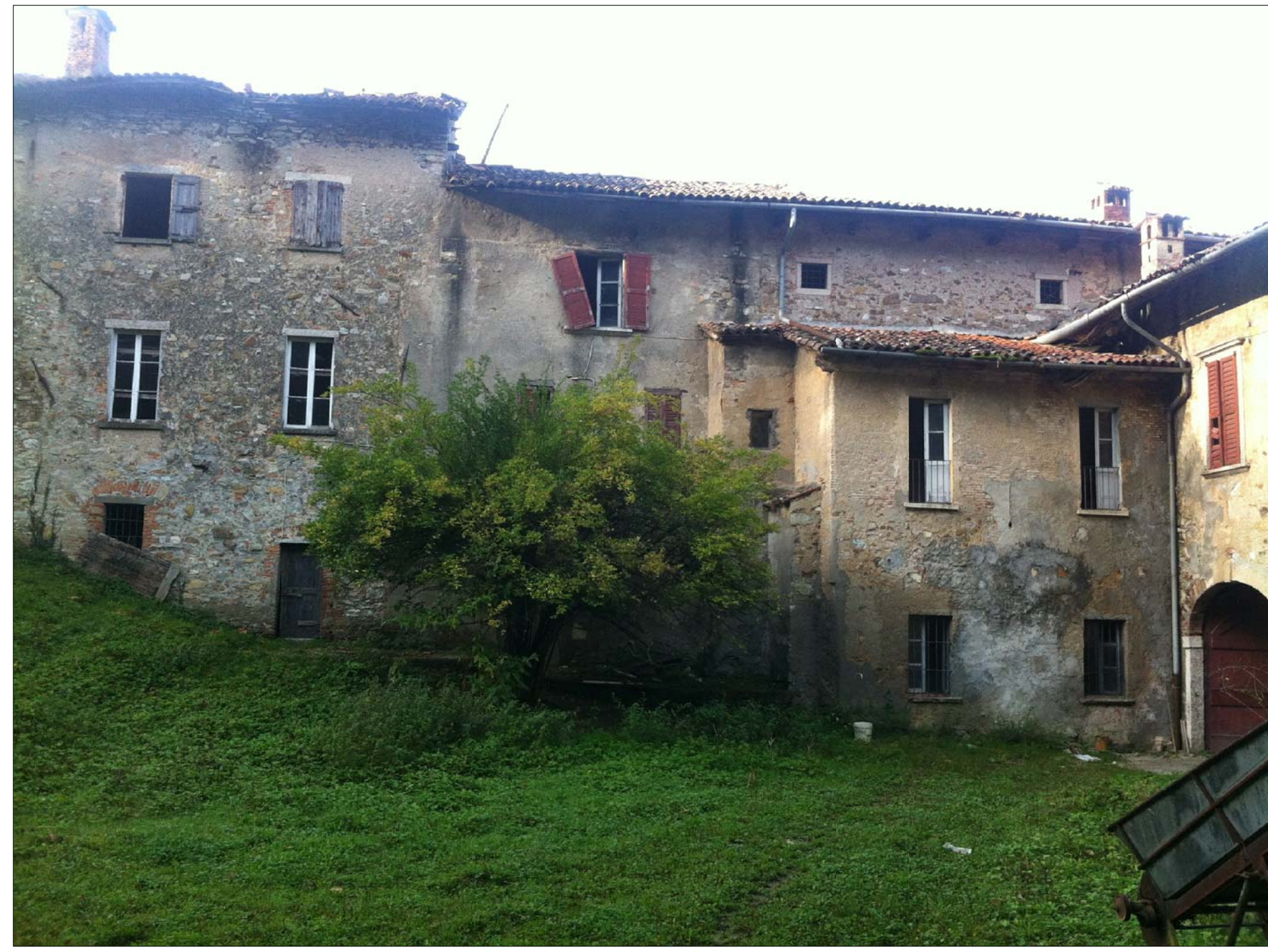
Vista dalla corte interna - angolo nordovest
